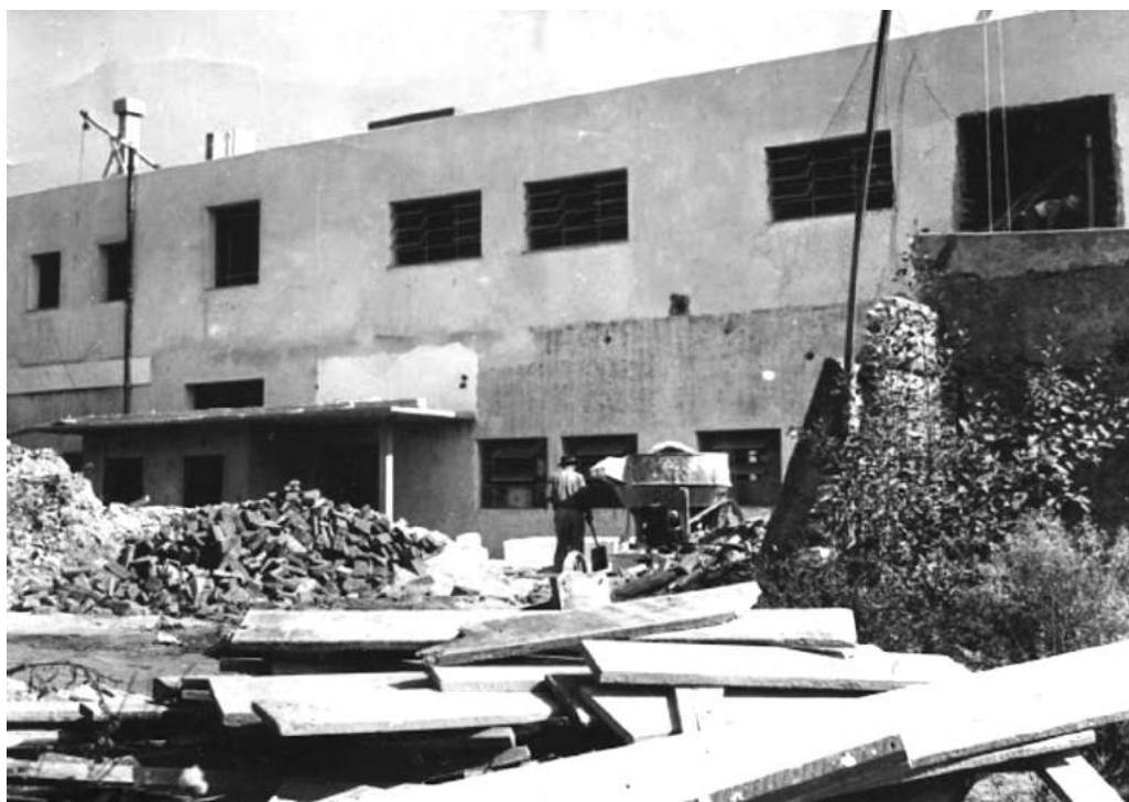
Remodelación del patio, conformación del 1er piso, Capilla y aulas. Verano, 1953-1954.
