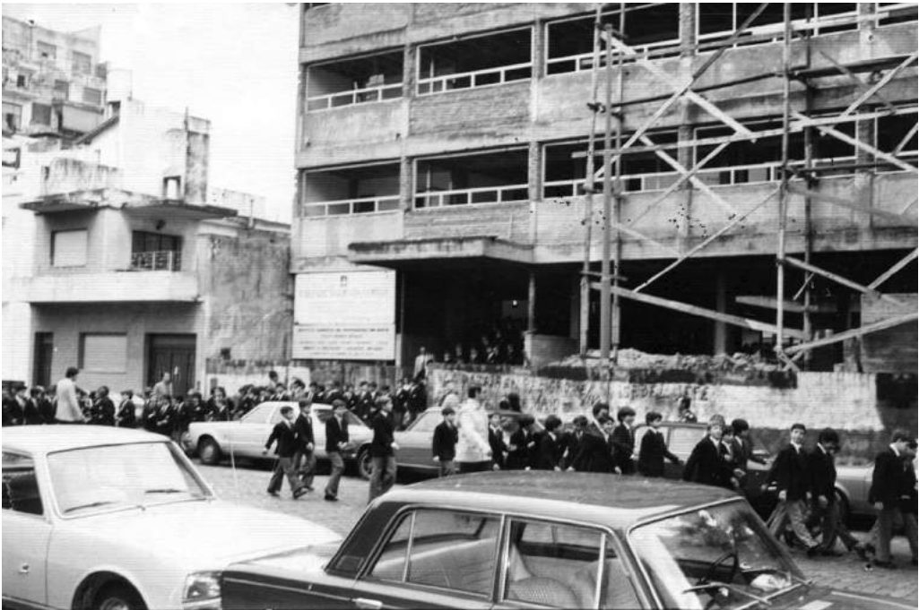
Desfile frente al edificio en construcción, calle Olazábal. 25 de Mayo de 1978.
