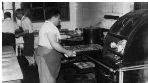
Cocina, Planta baja del edificio de Blanco Encalada, año 1953.
