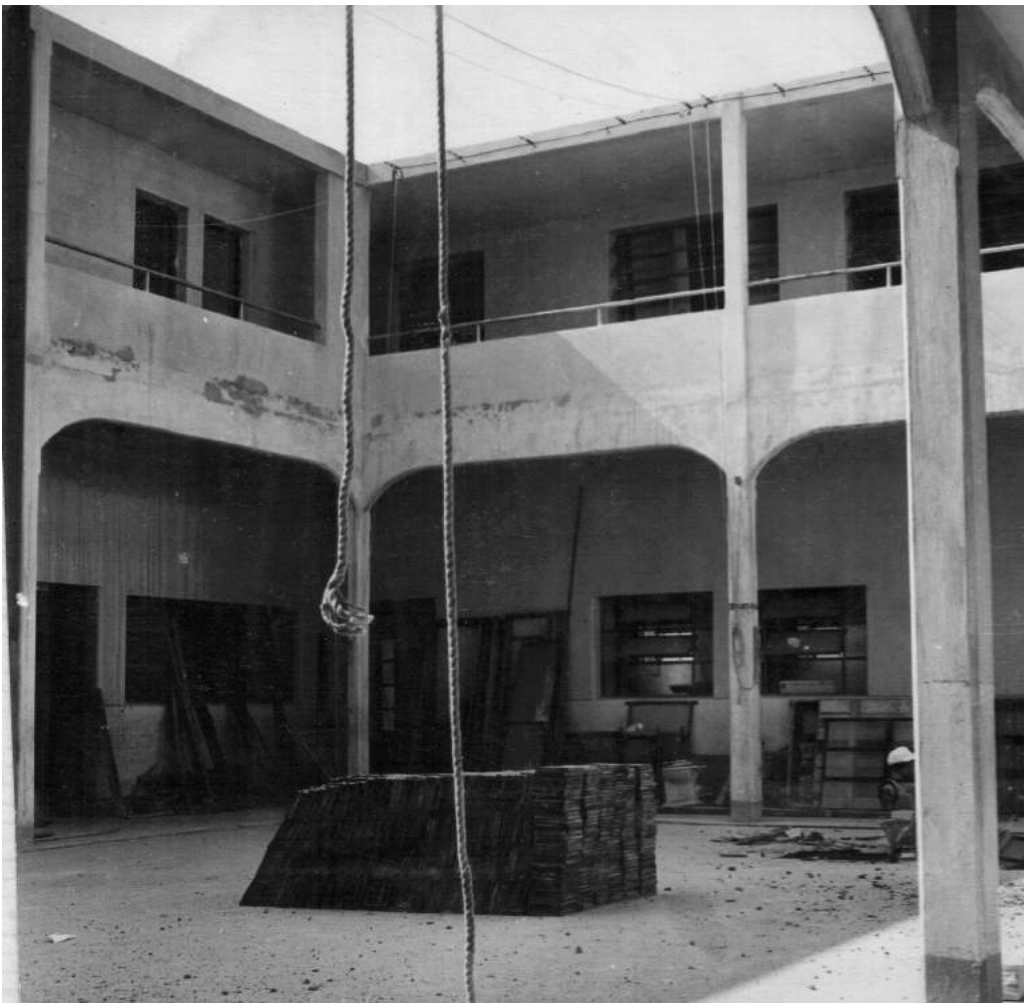
Ampliación y remodelación Edificio Blanco Encalada. Verano, 1953-1954.
